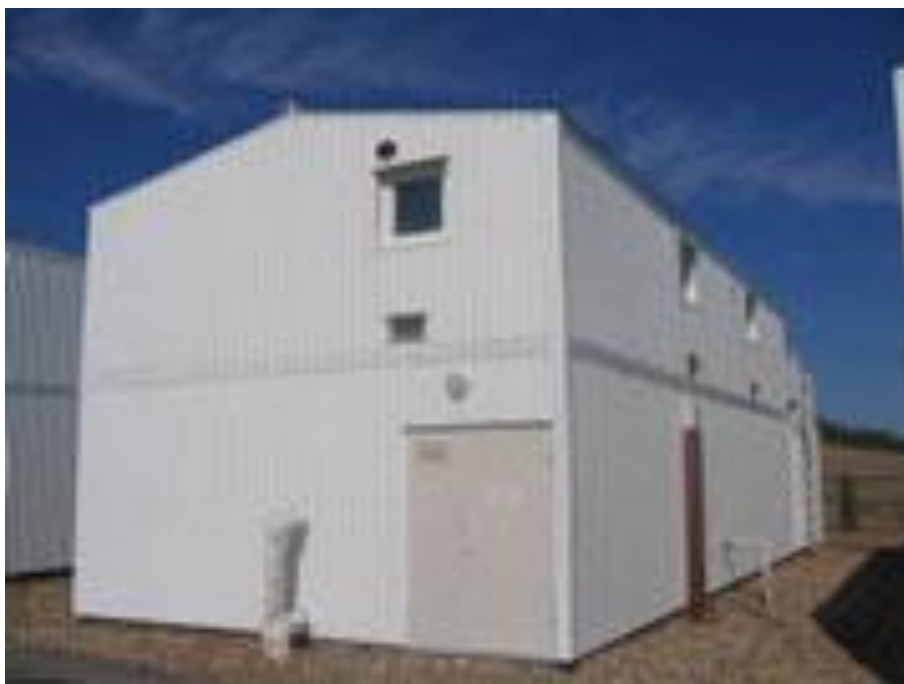
Рис. 8 Внешний вид очистных сооружений «Биоресурс»
